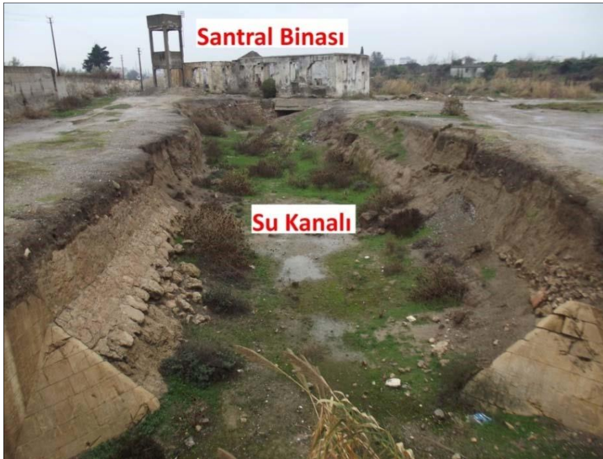
Resim 4: Tarsus Elektrik Santrali Su Kanalı. [1]
