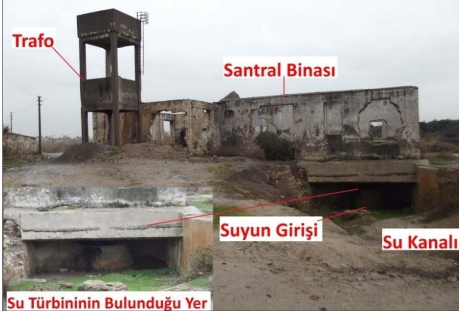
Fotoğraf 5: Tarsus Elektrik Santral Binasının Kuzey Cephesinden Görünümü. [1]
