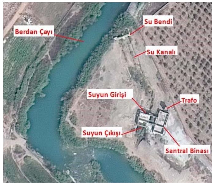
Resim 2: Tarsus Elektrik Santrali Yerleşkesinin Kuş Bakışı Görünümü. [1]
