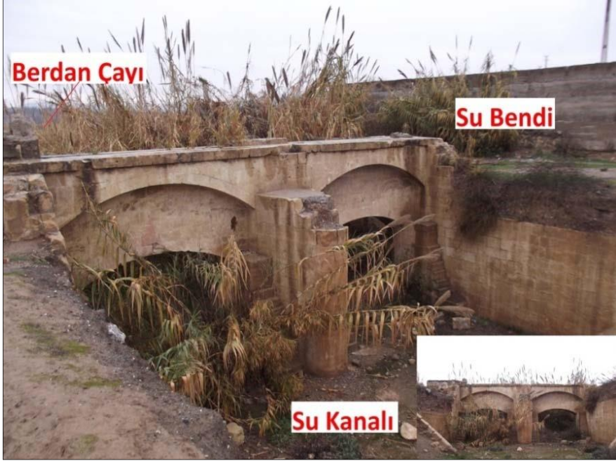
Resim 3: Tarsus Elektrik Santrali Su Bendi. [1]
