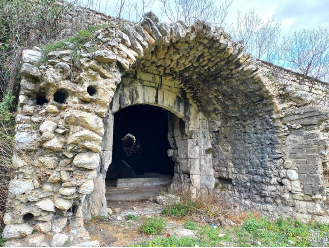
Şekil 3. Sarışih Hanı giriş eyvanı
