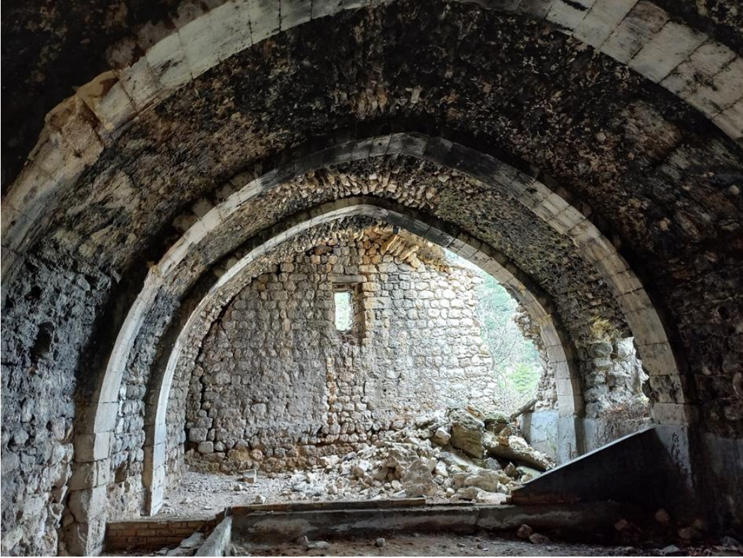
Şekil 5. Sarıış Hanı iç mekânı batı cephesi
