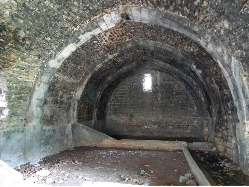
Şekil 4. Sarıış Hanı iç mekânı doğu cephesi
